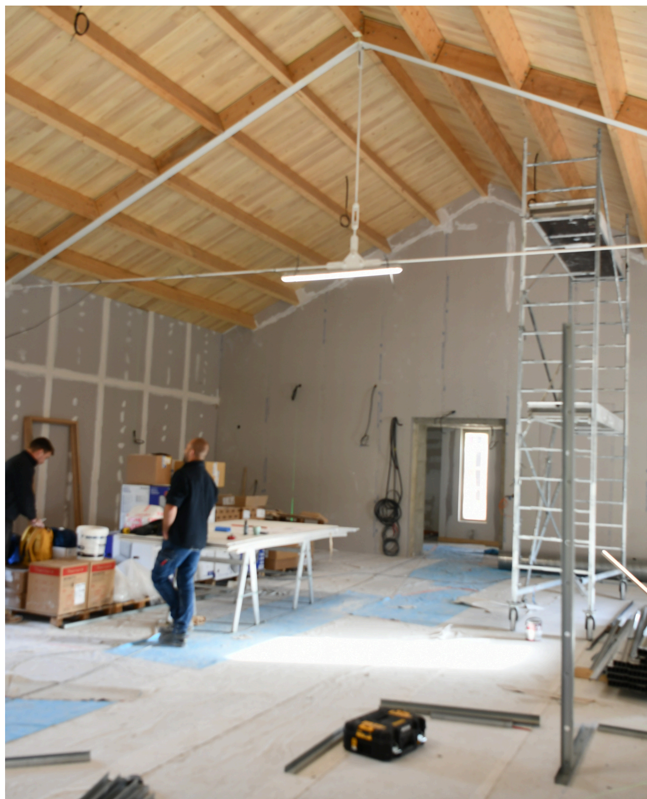
PHOTO DE LA BOUTIQUE EN CHANTIER
