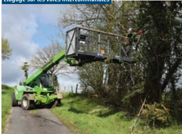
Élagage sur les voies intercommunales
