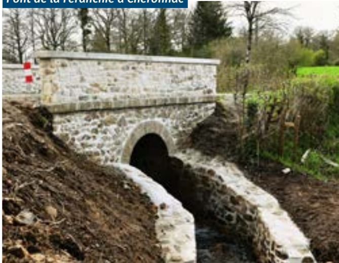
Pont de la Féranchie à Chéronnac
